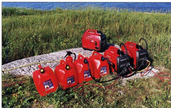
Zwei Generatoren vom Typ Honda EU-2000i versorgen uns zuverlässig mit Strom.
